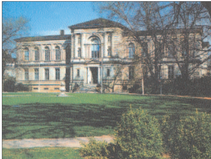
La facciata della bibliotheca augusta , corpo principale della Herzog August Bibliothek
