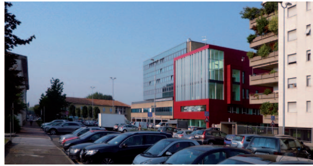
Confronto prima-dopo. Viste dell'edificio pre-esistente, rimasto incompiuto e abbandonato per vent'anni (foto 2009), e della MedaTeca (foto 2012). Dell'edificio pre-esistente è stata riutilizzata la struttura, rialzandolo di tre piani, modificandone le facciate, le caratteristiche architettoniche, tipologiche e materiche
