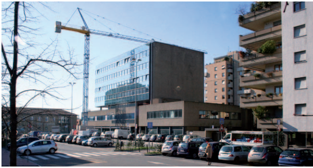
Confronto prima-dopo. Viste dell'edificio pre-esistente, rimasto incompiuto e abbandonato per vent'anni (foto 2009), e della MedaTeca (foto 2012). Dell'edificio pre-esistente è stata riutilizzata la struttura, rialzandolo di tre piani, modificandone le facciate, le caratteristiche architettoniche, tipologiche e materiche
