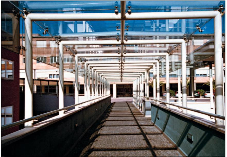
**I passaggi pedonali coperti con una sequenza modulare di portali metallici a sostegno di lastre piane di cristallo**
