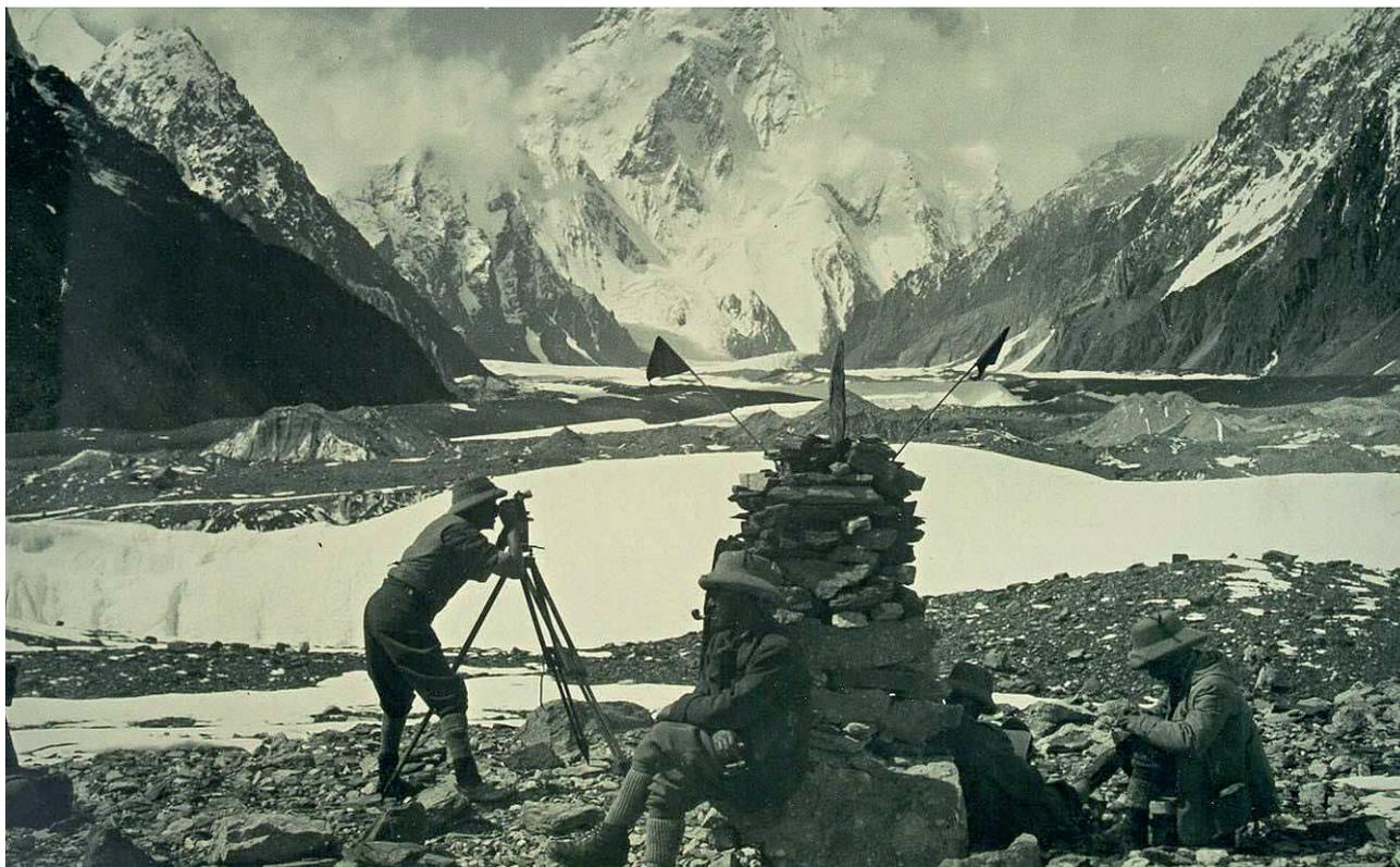
Ardito Desio mentre effettua un rilievo mediante un teodolite, 1929
