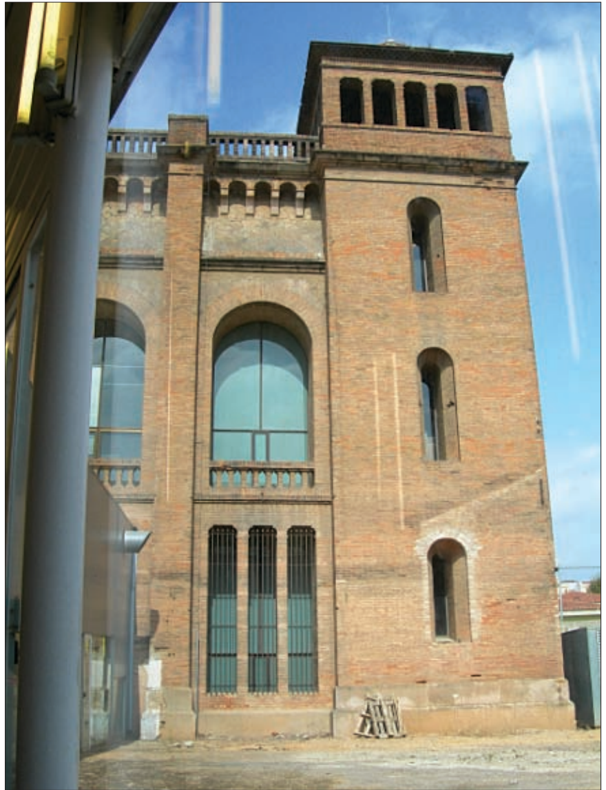
Una delle torri angolari che segnano il profilo del Dipòsit de les Aigües; all'interno una ripida scala a chiocciola porta fino al tetto-deposito. Si notino le alte finestre ad arco lungo i lati dell'edificio.
