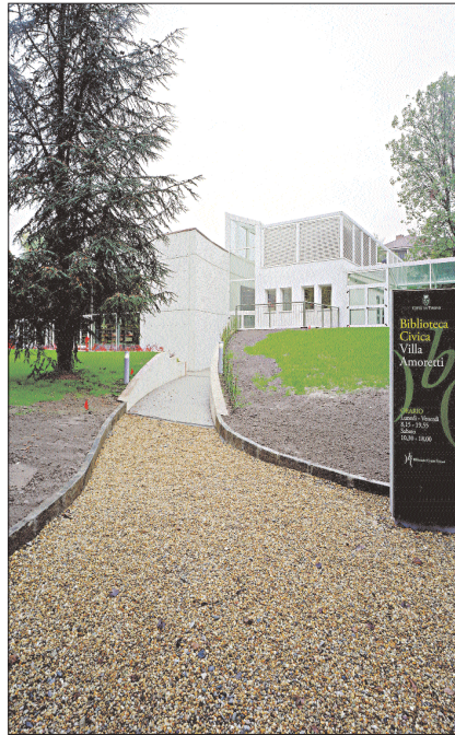
Biblioteca "Villa Amoretti": il nuovo padiglione che ospita la sala di lettura
