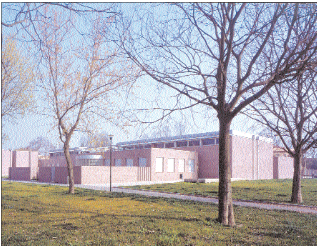
Esterno della biblioteca: fronte verso il parco
