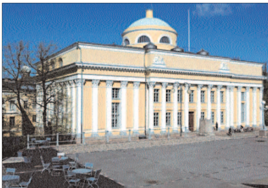
Facciata della Biblioteca nazionale di Finlandia
