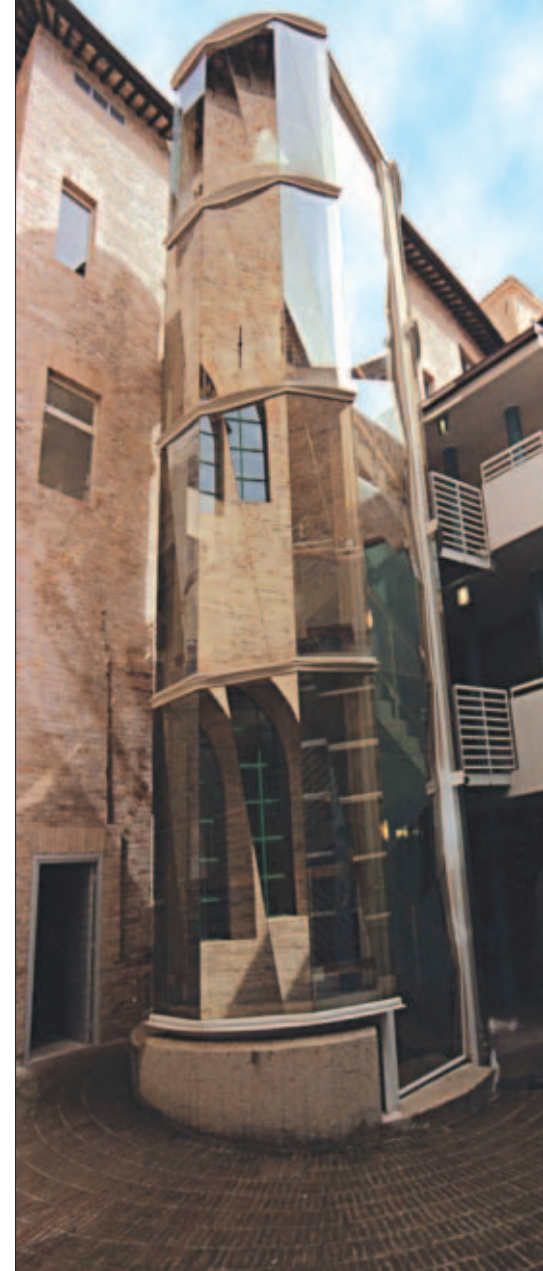
La torre-scala in vetro su cui si riflettono il cotto urbinato e le nuove strutture
