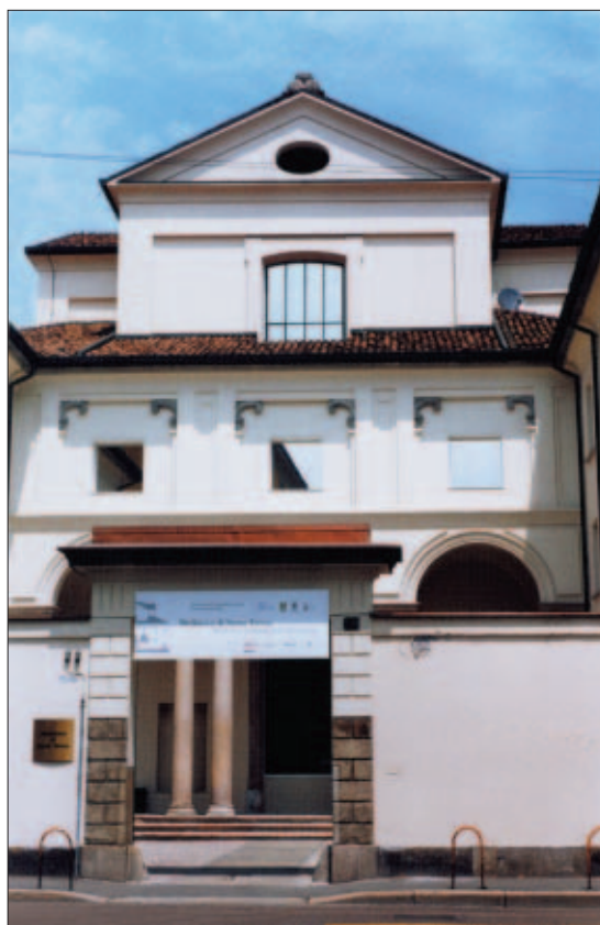
L'ingresso principale della nuova Mediateca di Santa Teresa
