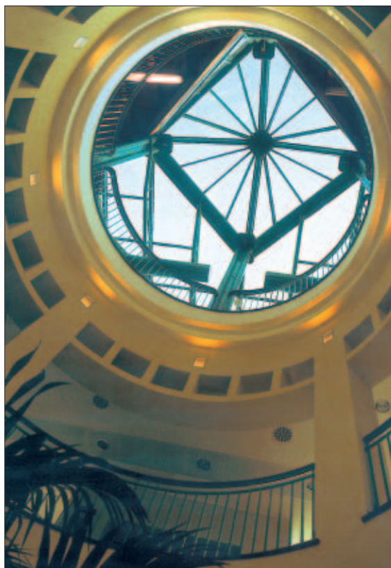
Un particolare della copertura a cupola visto dalla zona centrale del piano terra (foto L. Mussi)
