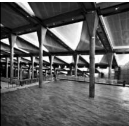
Le colonne che caratterizzano l'interno della biblioteca
